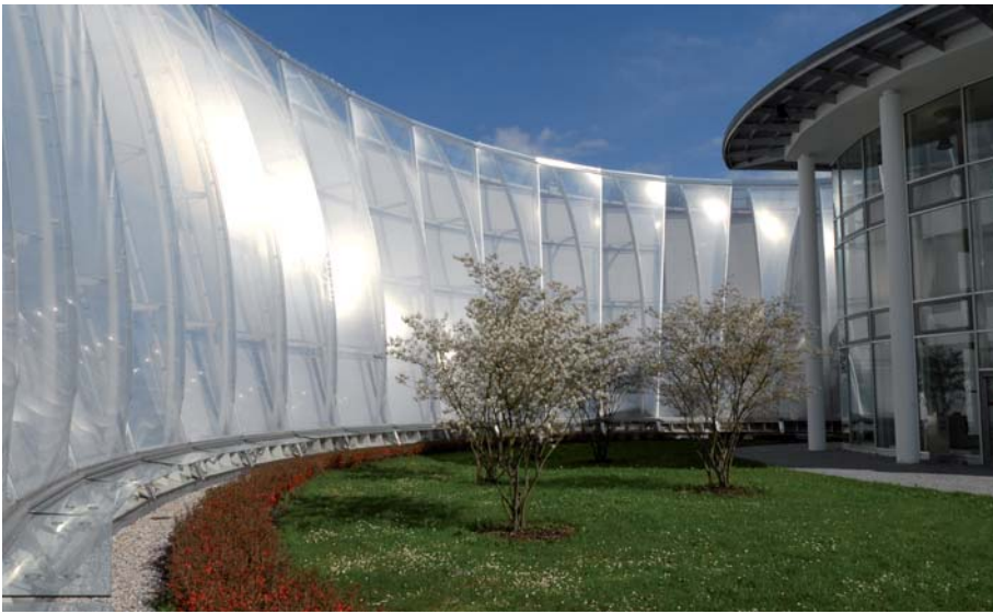
Abb. 4: Fassade aus ETFE-Folie am Gerontecentrum Bad Tölz
