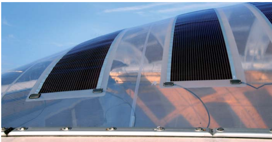
Abb. 3: PTFE-Kissen mit integrierten Photovoltaik-Elementen
