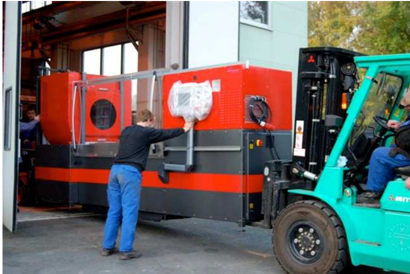
Anlieferung der neuen Cyclone-Anlage
